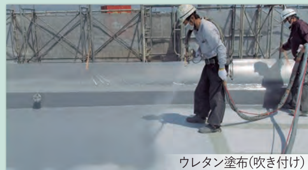
ウレタン塗布(吹き付け)
