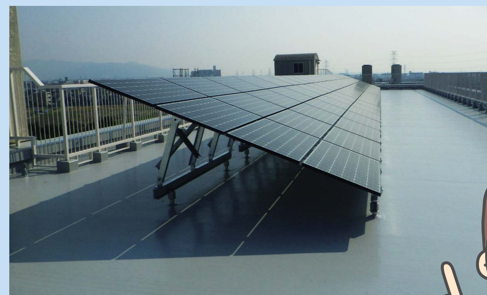
防水工事と太陽光パネル用の架台を同時施工(完成イメージ)
