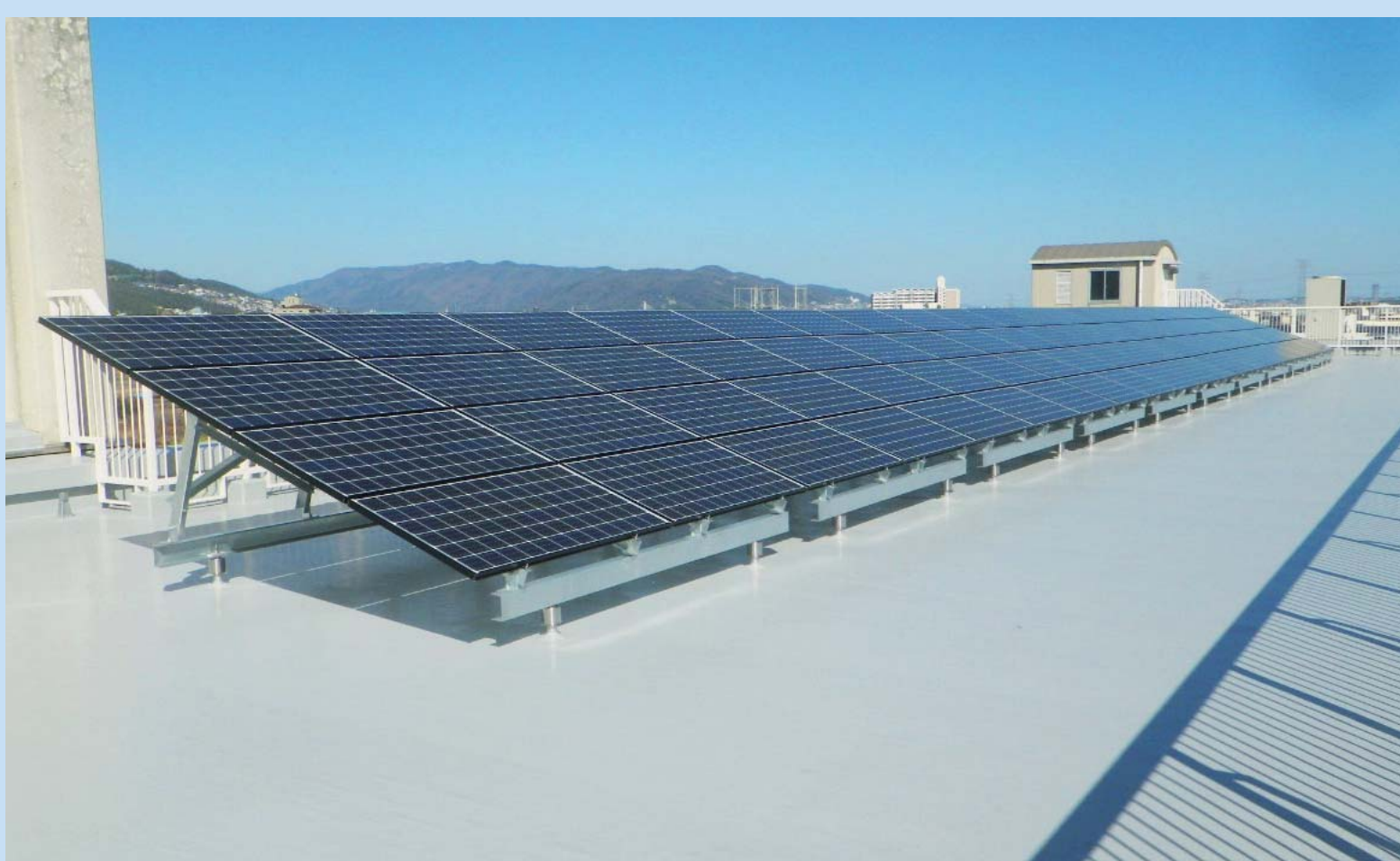
防水工事と太陽光パネル用の架台を同時施工(完成イメージ)
