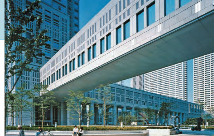
都庁第一本庁舎と第二本庁舎をつなぐ渡り廊下を含む約8,000㎡の外壁仕上げを担当。本庁舎外壁（天然石）に調色した石材調外壁仕上げにより軽量化を図り、30年以上経過した今も美しさを維持
